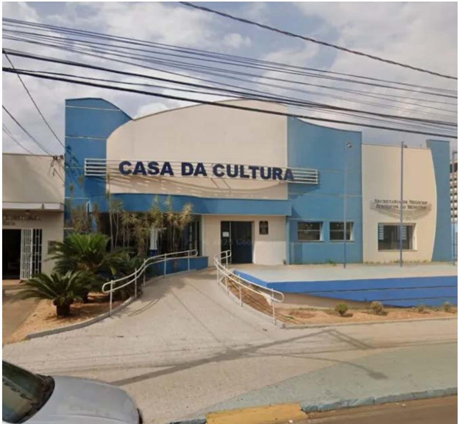
Casa da Cultura de Pedregulho (©GoogleStreetView)
