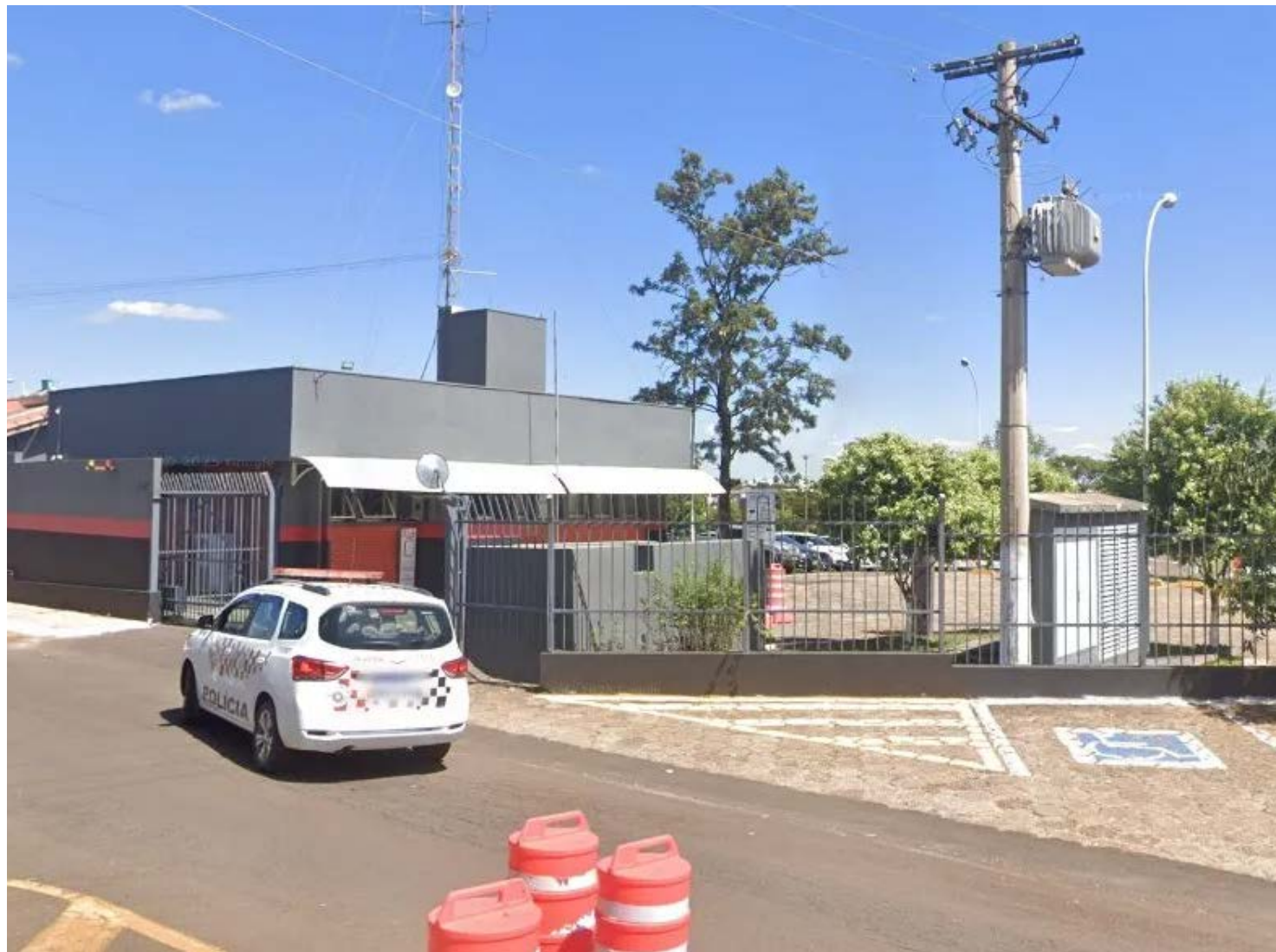
Sede do 15° BPMi, localizado na Rua Alfredo Tosi, 1.200, em Franca (©GoogleStreetView)
