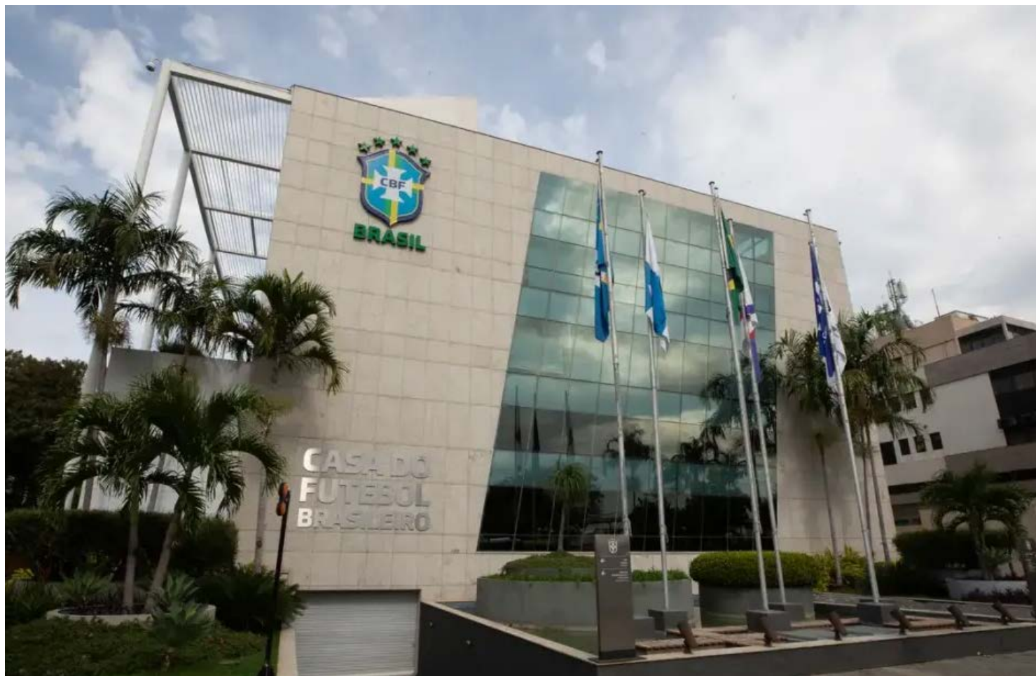
Sede da CBF, no Rio de Janeiro (©Lucas Figueiredo/CBF)
