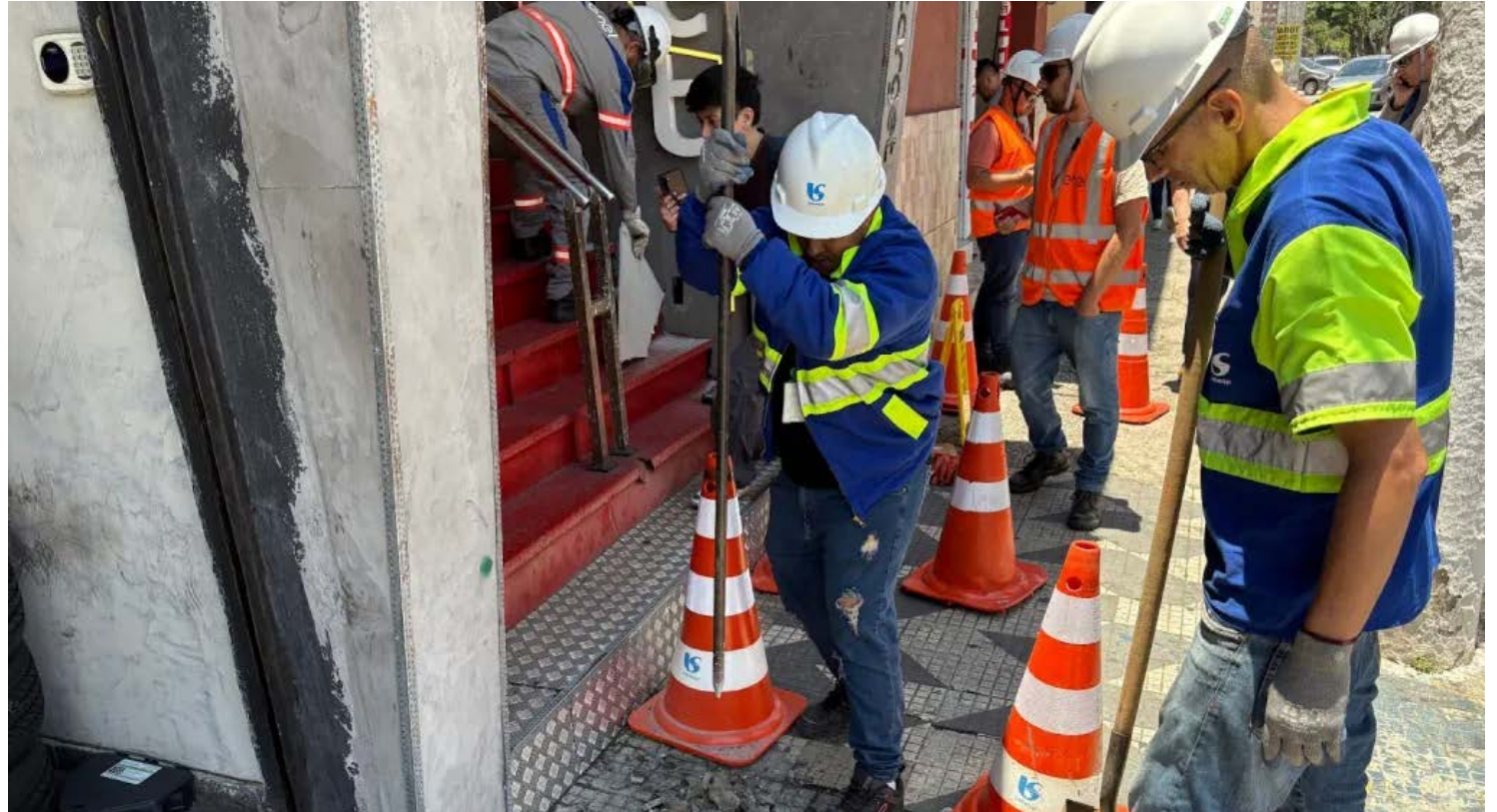
Equipes vistoriam e cortam fornecimentos clandestinos de água (©Divulgação/Sabesp)
