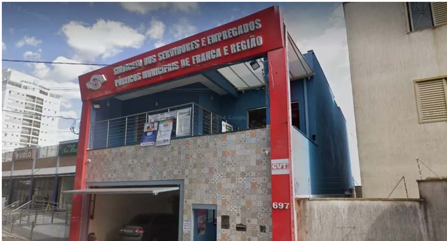
Fachada do Sindicato dos Sevidores e Empregados Públicos Municipais de Franca e Região (GoogleStreetView)
