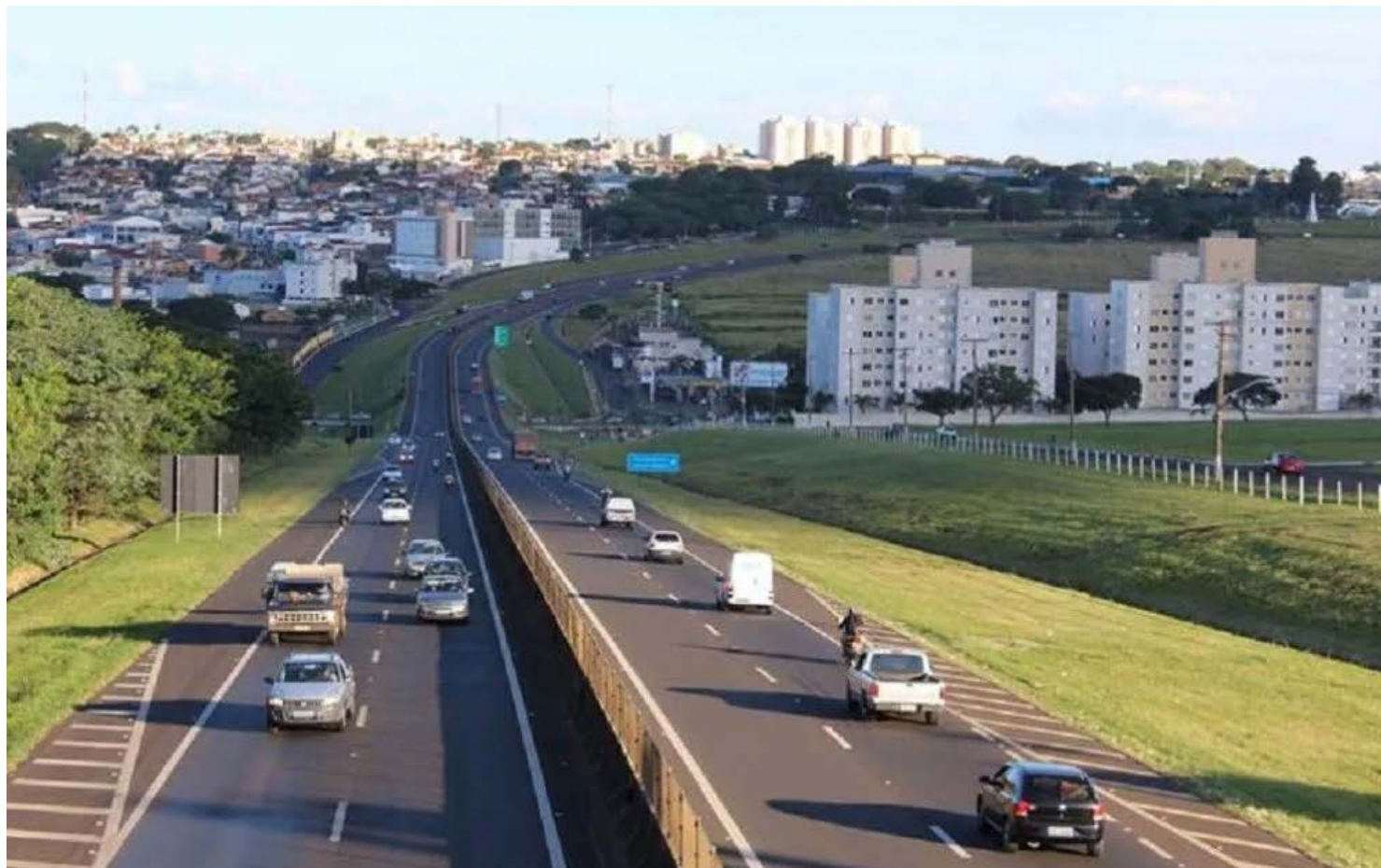
Rodovia Cândido Portinari, em Franca (©Fernando Lima)
