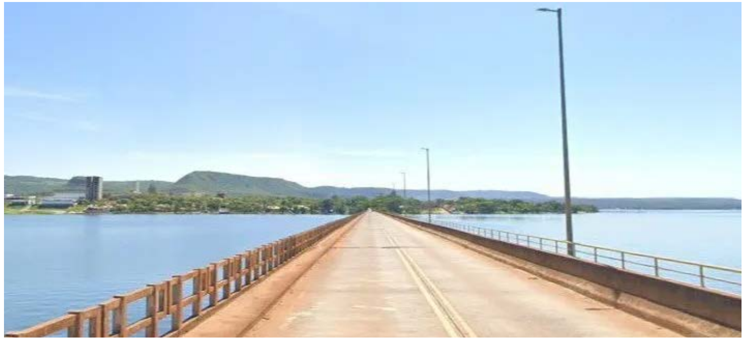
Ponte sobre o Rio Grande, entre os municípios de Rifaina (SP) e Sacramento (MG) (©Google Maps)
