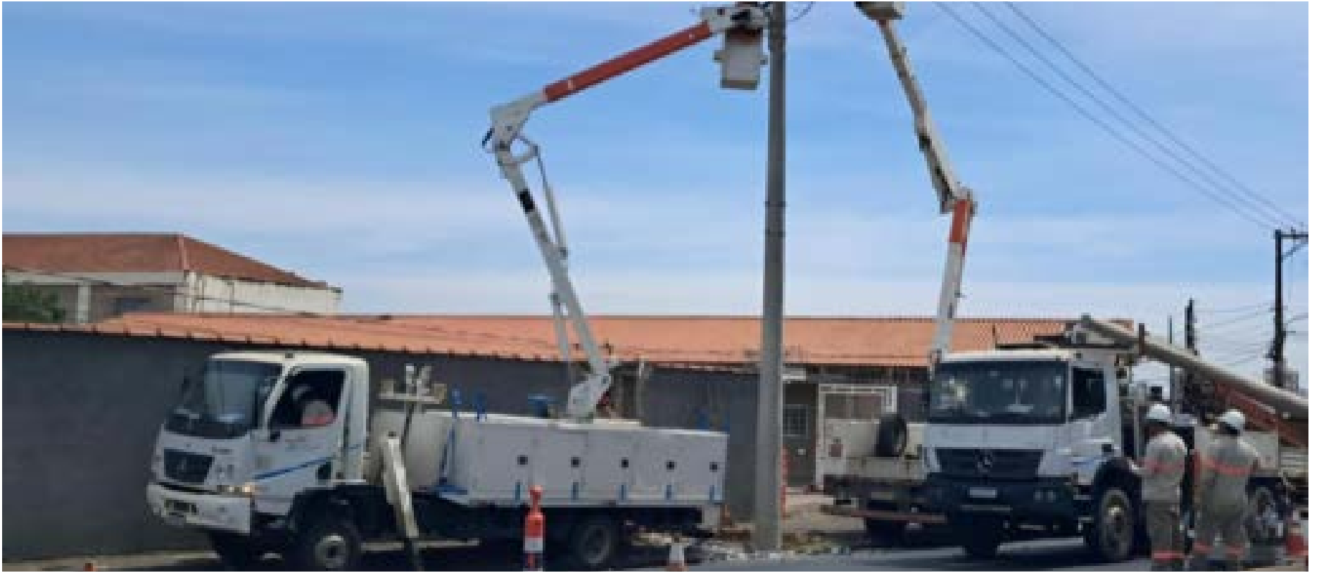
Equipes da CPFL reconstróem a rede após colisão contra poste (©Divulgação/CPFL)
