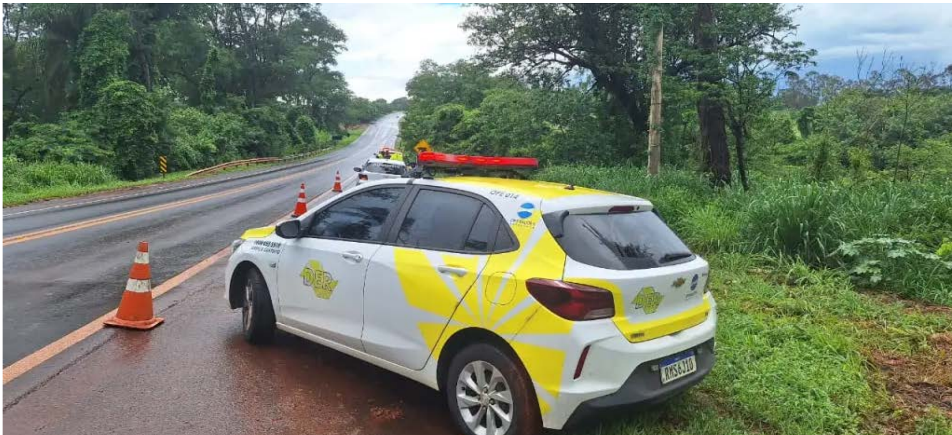
Ligação entre São José da Bela Vista e São Joaquim da Barra, no km 63 da rodovia, recebe serviços de recuperação e melhorias (©Divulgação)
